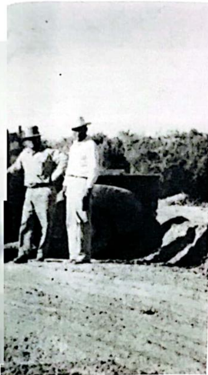
Construyendo caminos vecinales
